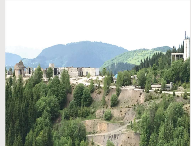
Veovaca processing site
