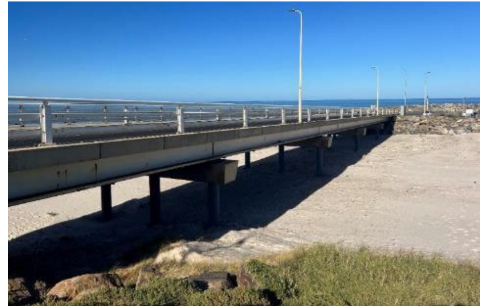
West Beach Bridge, Adelaide, SA
